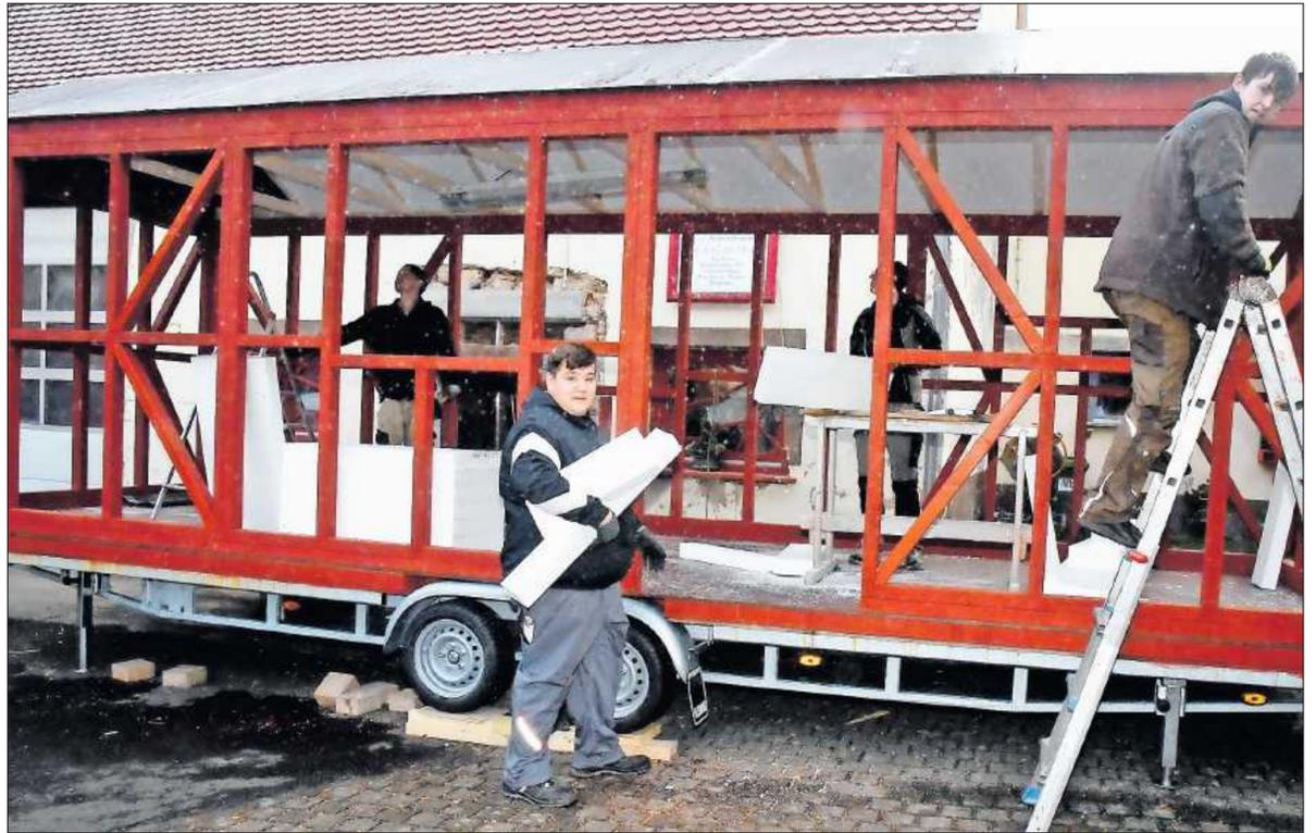
Das Grundgerüst steht. Derzeit arbeiten die Mitarbeiter der Schreinerei Matheis in Langmeil an der Dämmung des mobilen Tiny Houses. Vorübergehend hatte starker Wind den Fortschritt leicht verzögert. FOTO: SCHIFFERSTEIN
